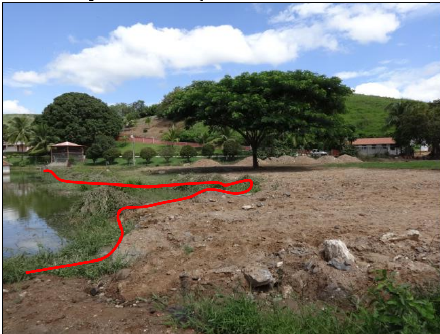
Figura. 04 - Intervenção em APP do reservatório.
