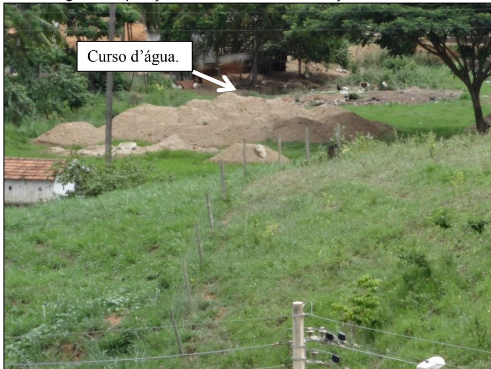
Fig. 2 - Disposição de resíduos da construção civil em APP.
